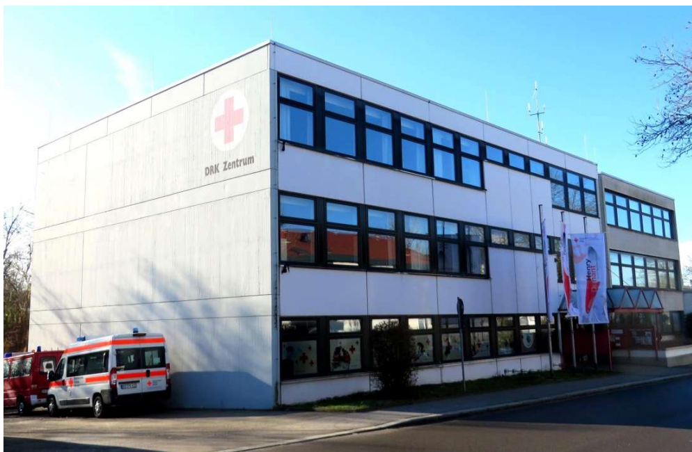
Steht dem Radschnellweg aus Stuttgart im Wege: das Vereinsheim Albert-Schweitzer-Haus des DRK-Ortsvereins Sindelfingen in der Waldenbucher Str.40 in Sindelfingen
